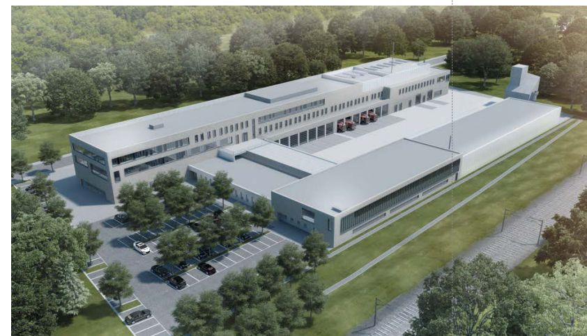
Gebäudeentwässerung Feuerwache Leverkusen, Deutschland
