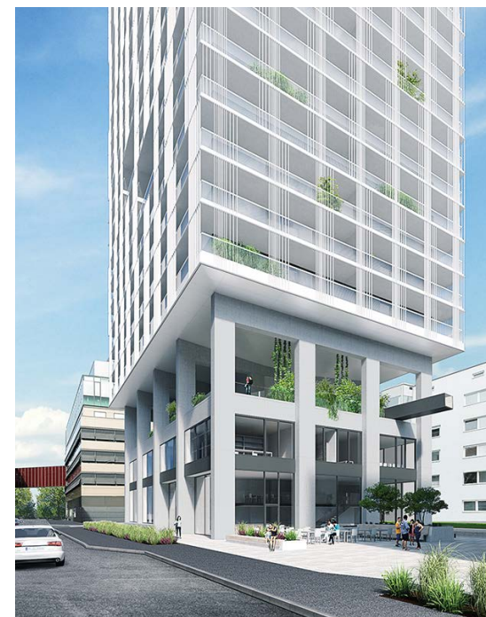
Gebäudeentwässerung Lux Tower mit 22 Stockwerken in Linz, Österreich
